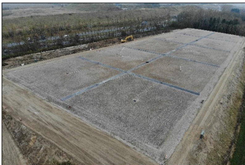
Figure 7-17: Aerial view of the PTES in Høje Taastrup, Denmark [87].
